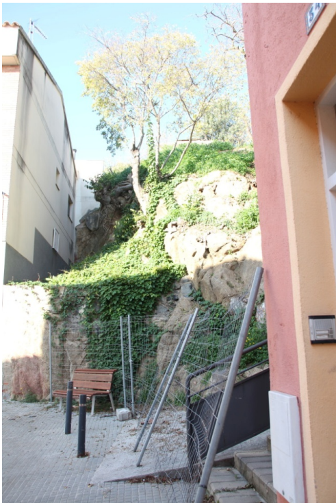
Imatge 10: Vista del talús enfront l'habitatge del carrer Aragó.
