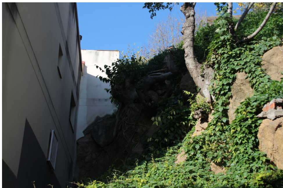
Imatge 2: Vista del talús enfront l'habitatge del carrer Aragó.
