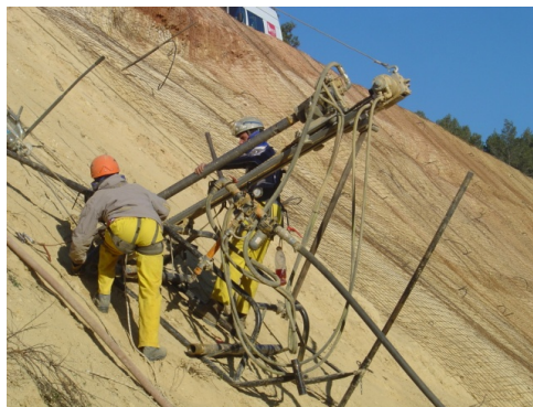
Imatge 5: Exemple d'execució dels ancoratges
