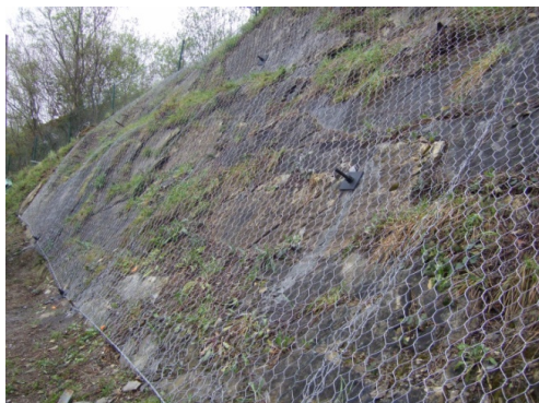
Imatge 4: Exemple de malla ancorada
