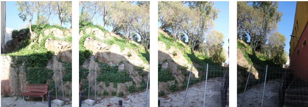
Imatge 7: Vistes del talús.
