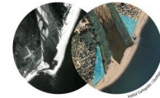
Construcció d'esculleres a la zona de desembocadura 2001
