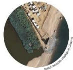
Infraestructures relacionades amb la dessalinitzadora 2001
