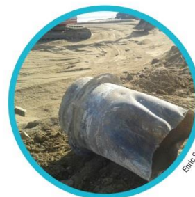
Retirada dels pous de la dessalinitzadora
