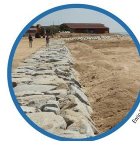
Regeneració artificial: Ampliació de les esculleres de protecció
