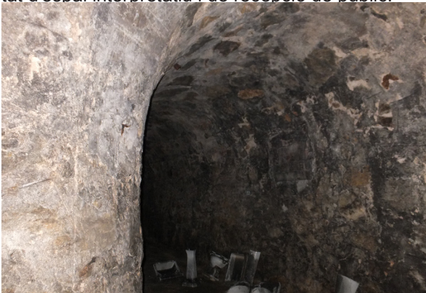
Detall de la volta constructiva del túnel del "Carregador de la Mina".
