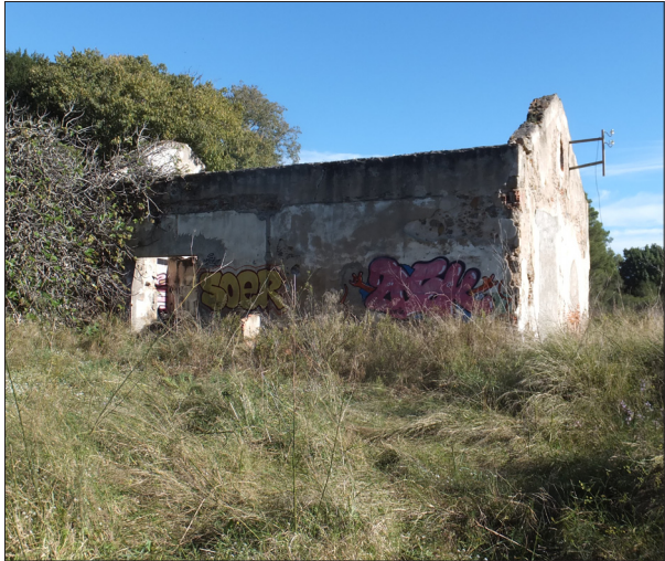
Detall de la construcció annexa al "Carregador de la Mina" de la qual només en queden les parets.
