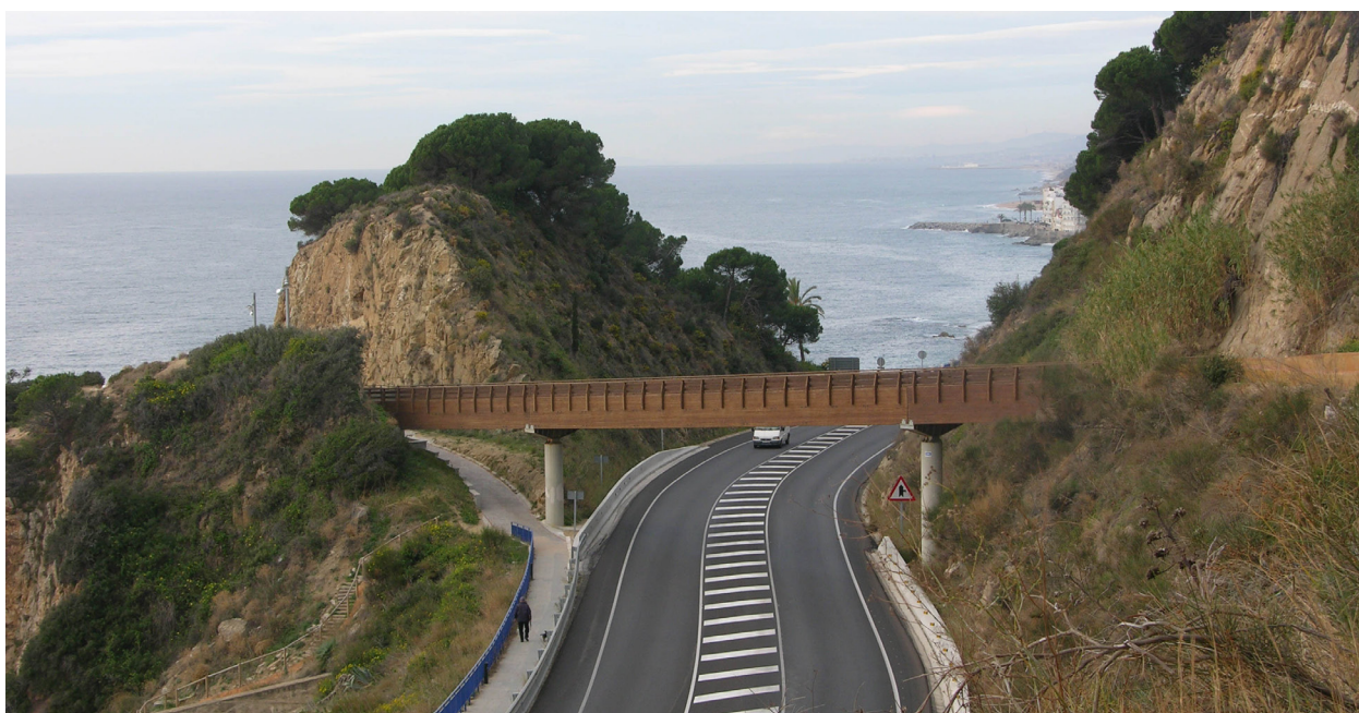
Exemple d'una passera sobre la NII (Sant Pol de Mar) construïda per accedir a un indret d'interès turístic, que pot ser el cas de l'accés al carregador de la Mina, tal com es proposa.
