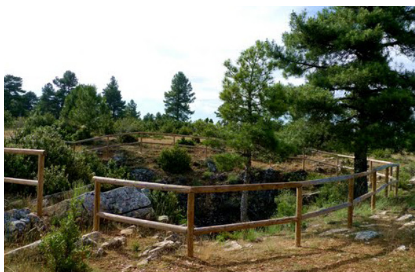
Exemple d'una forma senzilla, barata i efectiva per protegir d'accident la boca dels pous de ventilació..
