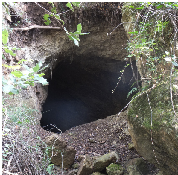
Boca de l'accés intermedi a la Mina Gran (mina 8), clarament en procés de colmatació per desprendiments.
