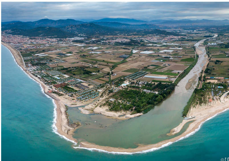
Imatge de Roger Rovira captada amb un dron que fa palès la vulnerabilitat del territori inundable que ocupen els càmpings de la Punta de la Tordera.
