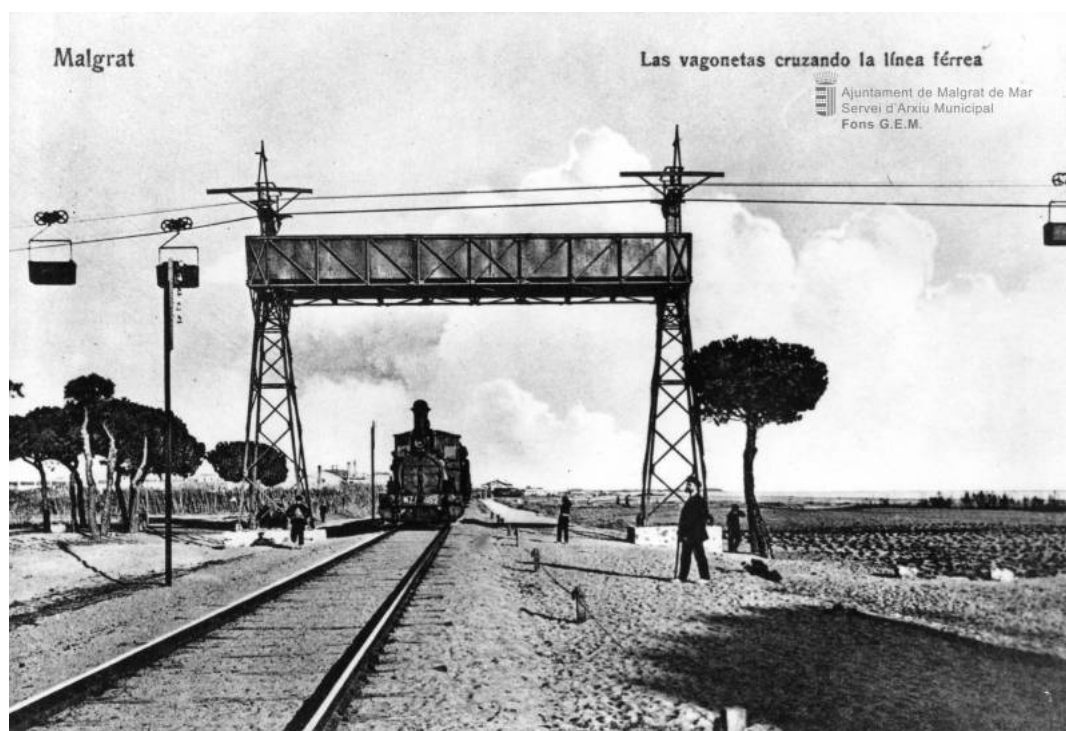
L'aeri passant per sobre de la via del ferrocarril, amb el pont de protecció (AMMM, fons G.E.M.)
