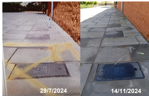
Figura 1. Fotografies de la zona de la caiguda amb les peces prefabricades prèviament (fotografia en data del 29/7/2024) i posteriorment (fotografia en data del 14/11/2024) reparades.
