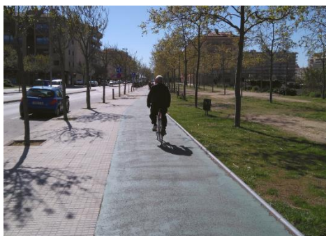
Figura 3.25.– Carril bici sobre a l'avinguda dels Països Catalans
