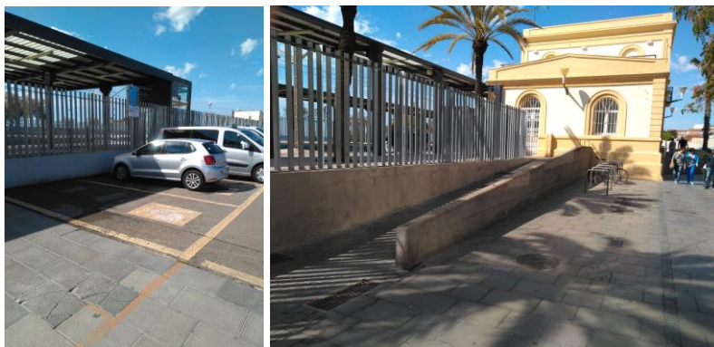
Figura 3.33.– Aparcament per a PMR i rampa de sortida de l'estació (a l'extrem nord). Font: elaboració pròpia
