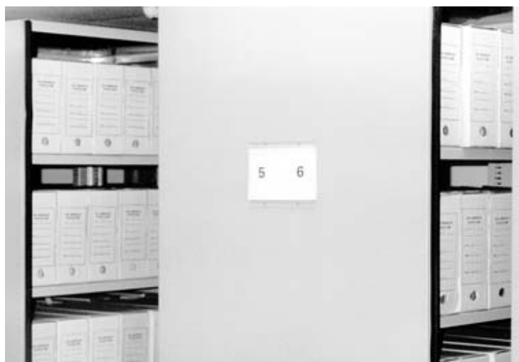
Detall dels armaris compactes del dipòsit de l'Arxiu Municipal de Malgrat de Mar.
